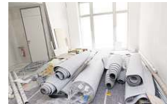
Auch am Wochenende waren im neuen Haus noch Baustellen zu sehen
