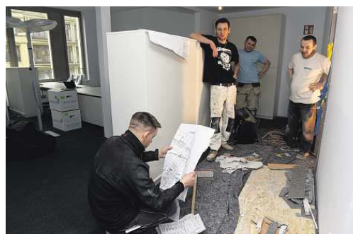
Die Fliesenleger studieren die Pläne des Neubaus. Bis zur letzten Minute arbeiten Handwerker auch in den Nebenräumen
